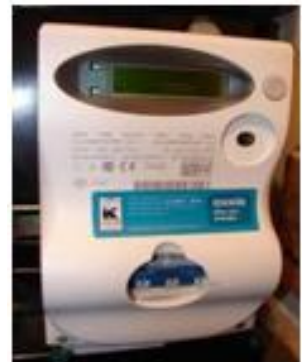
Digitale meter zonder teruglevermogelijkheid
