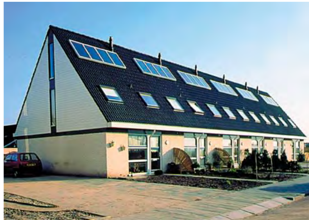
Vlakke plaat collectoren geïntegreerd in het dakvlak.
