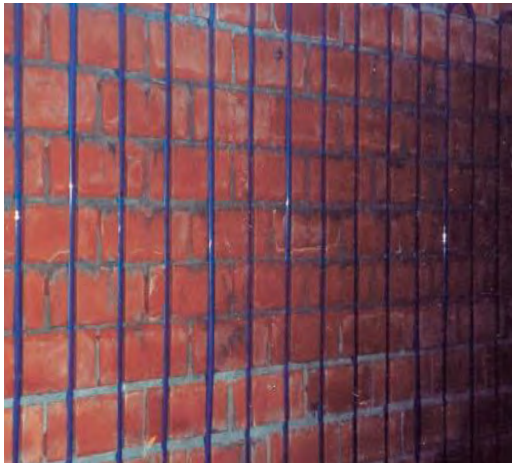
Deze wand wordt voorzien van wandverwarming.
