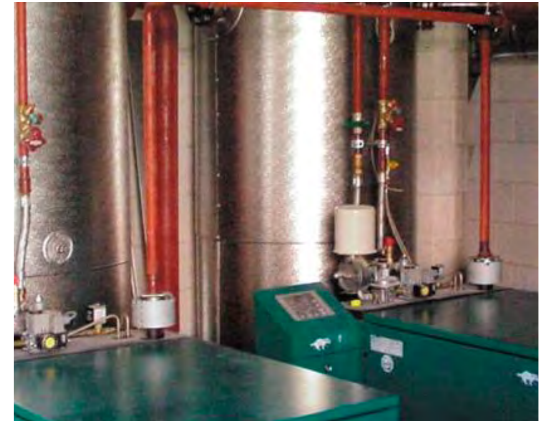
Een miniwarmtekrachtinstallatie kan een kleine cluster van woningen of een klein woongebouw voorzien van energie.
