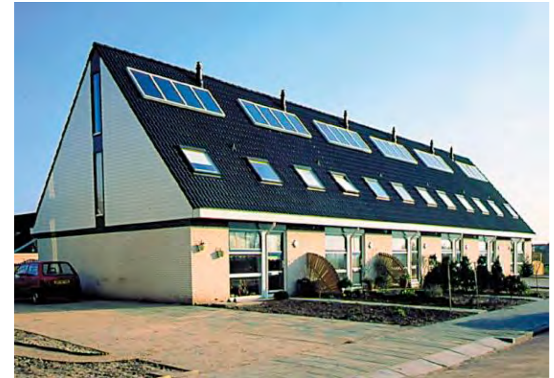
Vlakke plaat collectoren geïntegreerd in het dakvlak.
