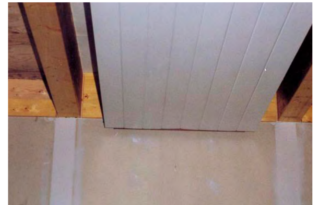
Een koelplafond kan als element tussen de (houten) draagstructuur worden geplaatst.
