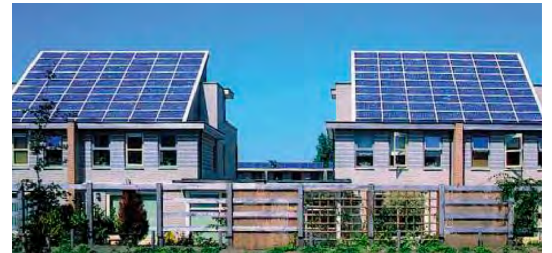
Pv panelen geïntegreerd in het dakvlak.
