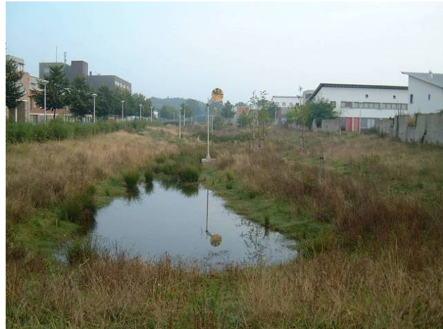
Figuur 4 Ecologische wadi Grootstal, na regenbui
