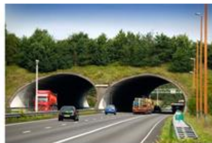
Ecoduct Woeste Hoeve over de A50 Bron: www.rijkswaterstaat.nl
