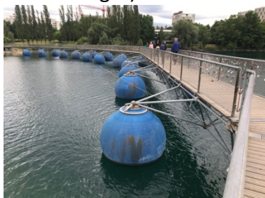
Figure 3: Een milieuvriendelijke pneumatische pontonbrug in Freiburg, Duitsland (Foto © Gultekin Cakmakci)
