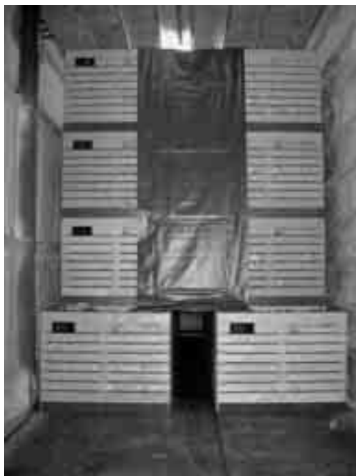
Fig. 11.8 Kisten in een zuigluchtbewaring. Het zeil dekt de zuiggang af.
