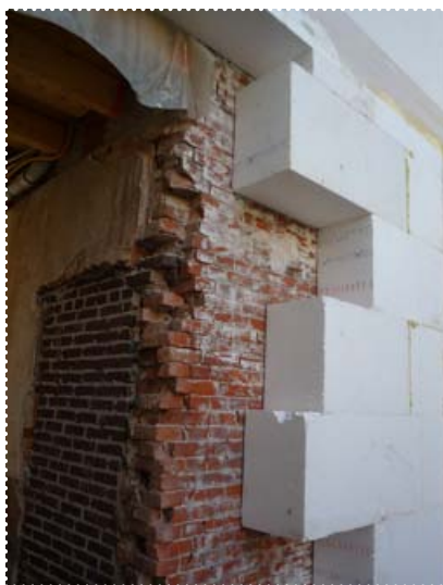
Achterzijde met isolatie aan de buitenkant.
