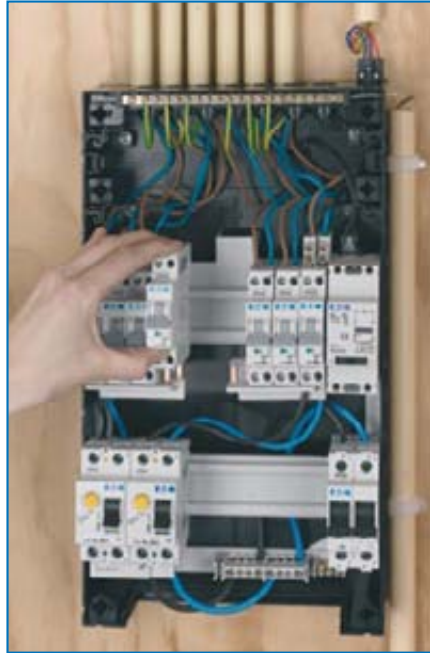
Eenvoudig bijklikken van installatieautomaten op voorgesloten railaansluitkammen.
