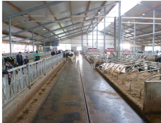
Herakles (gietasfalt op afschot met giergoot)
