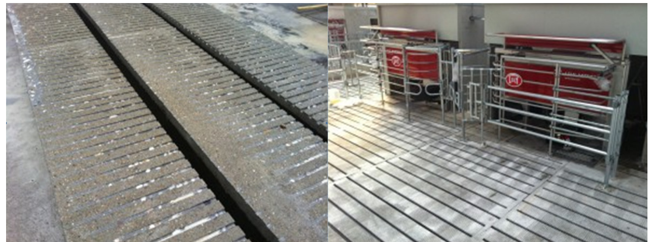
Swaans beton G3 vloer
