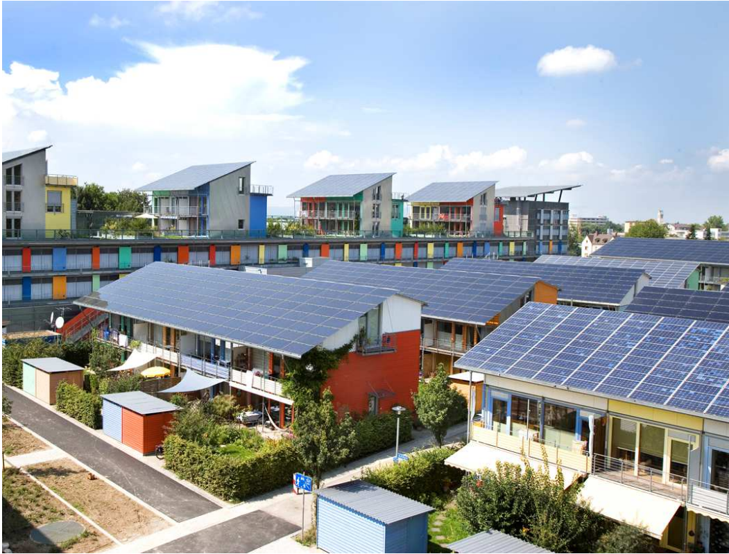
Solar Siedlung Freiburg (D) Architect: Rolf Disch
