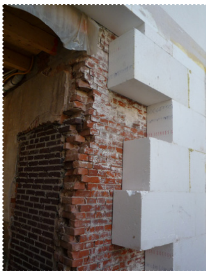
Achterzijde met isolatie aan de buitenkant.
