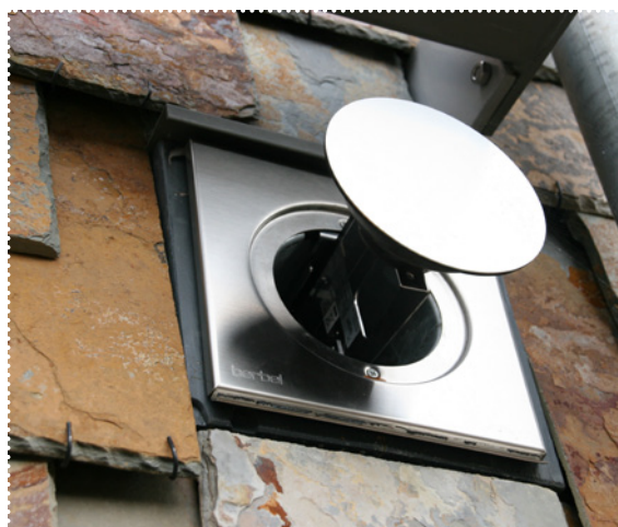
Automatisch openschuivend rooster voor de afzuigkap.
