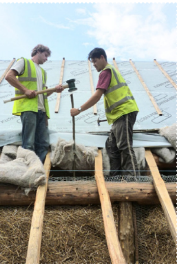
Wol en stro zijn goede ecologische isolatiematerialen.
