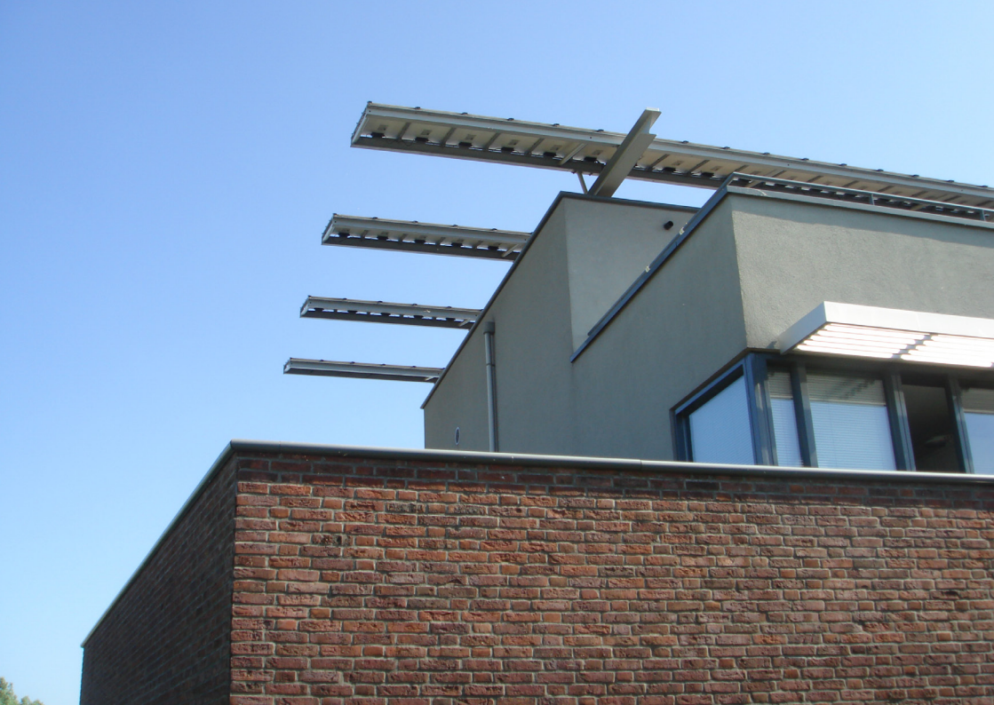
Project Down 2-000 - Etten Leur - zonnepanelen op een speciale dakconstructie
