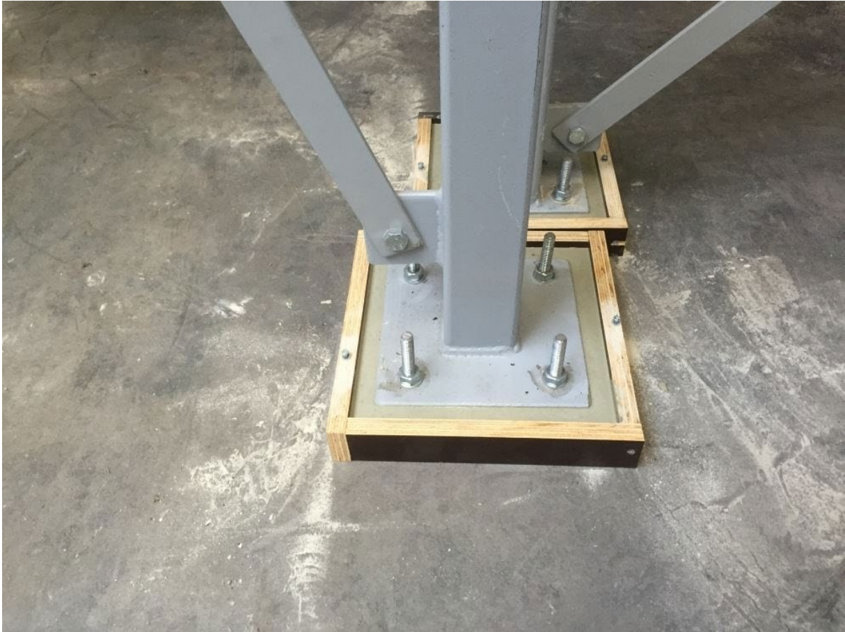
Afbeelding 6 Kolomvoet met schetsplaat en verbinding met schoor
