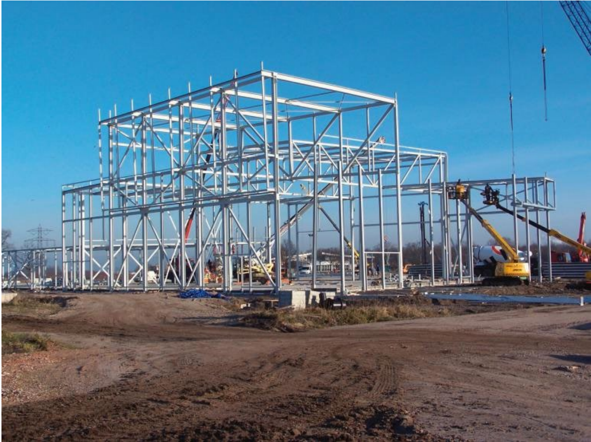
Afbeelding 7 Kolommen en liggers met schoren en windverbanden
