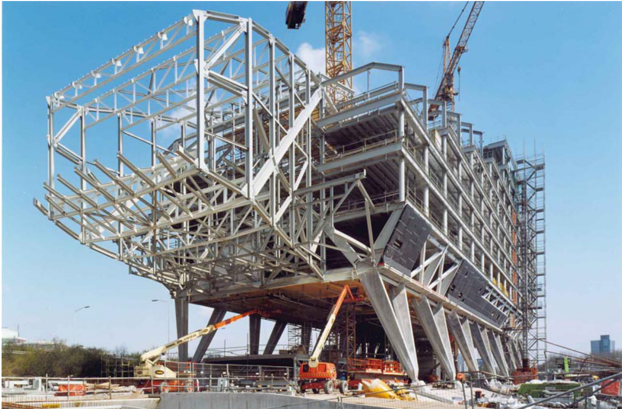
Afbeelding 1 Voormalig hoofdkantoor ING de Schoen: combinatie van staalframebouw en staalskeletbouw
