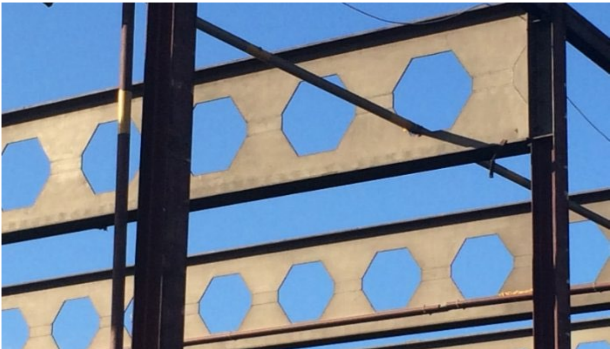
Afbeelding 4 Raatliggers in dakconstructie
