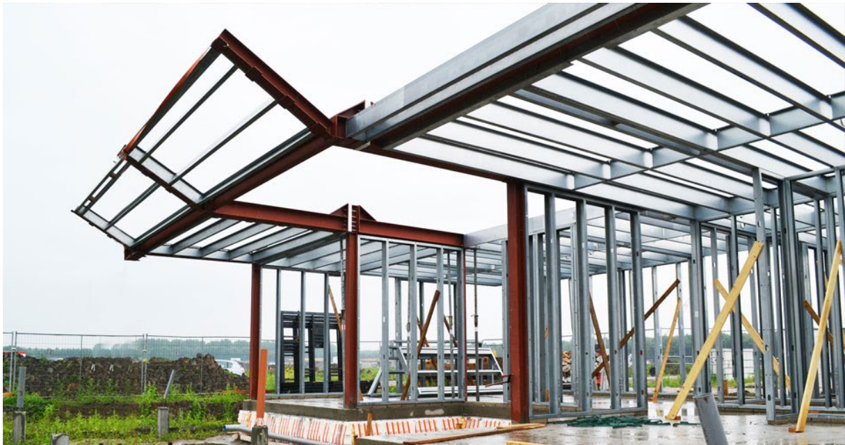
Afbeelding 18 Combinatie van staalframebouw en staalskeletbouw
