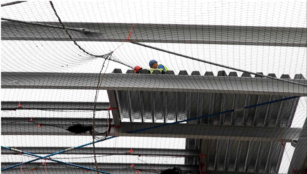
Afbeelding 15 Geprofileerde stalen dakplaten met vangnetten met zeeg
