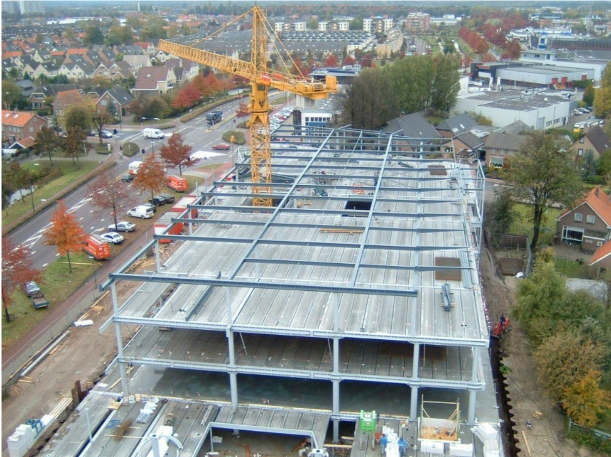
Afbeelding 13 Kanaalplaatvloeren in staalbouw
