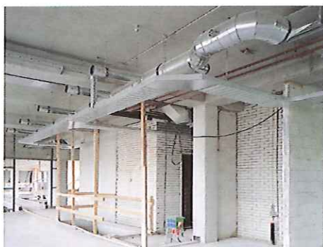
Fig. 7a Kabelgootsysteem in de praktijk
