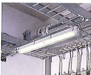
Fig. 15 Verlichting op railkoker
