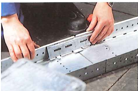
Fig. 7d Koppelstuk voor kabelgoot
