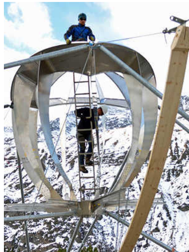
De opbouw van een prototype van de kunstmatige sneeuwwoik.
