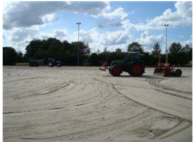
10. Aanbrengen 4 cm verschrallingszand
