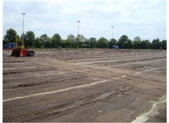
9. Weghalen van de overtollige grond
