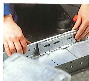
d Koppelstuk met klikverbinding
