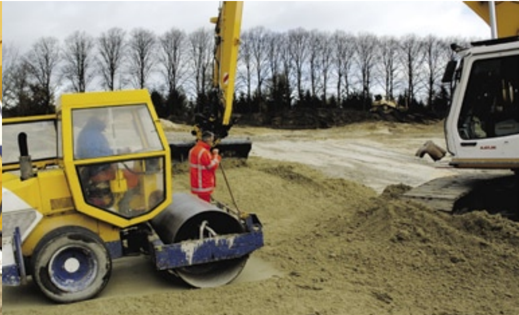
Trisoplast oogt als gewoon zand, maar voelt erg kneedbaar en kauwgomachtig aan. Het laat zich heel makkelijk aanbrengen, verdichten en boetseren waardoor alle contouren goed te volgen zijn.
