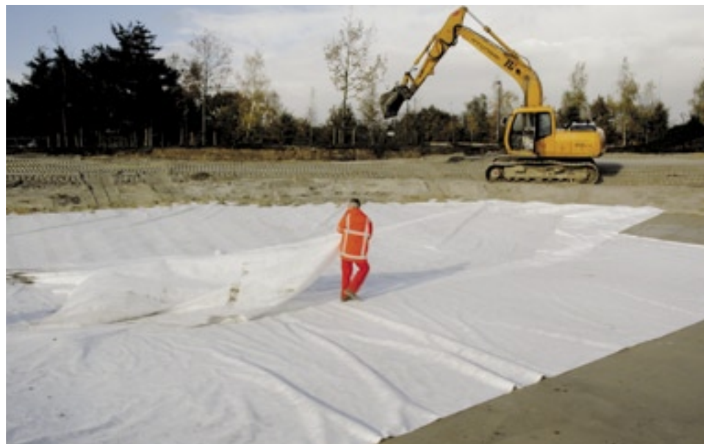
Bij vijvers wordt meestal op de Trisoplast nog een signaleringdoek aangelegd. Dit voor het geval er later in gegraven wordt.
