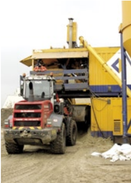
Bij de aanleg van vijvers met Trisoplast op een nieuwe golfbaan gaat het ook bij een laagdikte van 6-7 centimeter om behoorlijk wat kuubs. Daarom worden zand, betoniet en polymeer ter plaatse gemengd: 1.000 kilo zand, 130 kilo bentoniet en 2,6 kilo polymeer.
