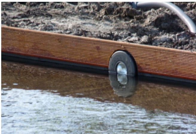
Afwerking met afdeklath. Waterniveau komt 3 cm onder de bovenrand (hier nog niet bereikt). In de randafwerking is een spotlight gemonteerd.
