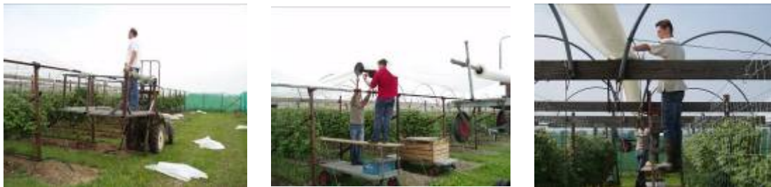
Foto 35, 36, 37: Door het hydraulisch oprollen van een touw (links) wordt de folie over parabolische rollen getrokken. Aan het begin van het perceel (midden) en op twee andere plaatsen verdeeld over het perceel wordt gecontroleerd of de folie goed over de rollen blijft lopen (rechts).
