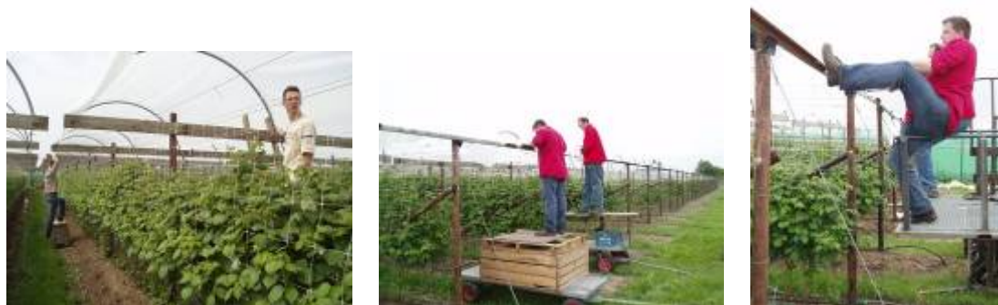
Foto 38, 39, 40: Nadat de folie over de rij is getrokken wordt deze over de bogen getrokken (links), aan één kant vastgezet aan de onderbouw (midden) en dan aan de andere kant strak getrokken (rechts) en eveneens vast gezet.
