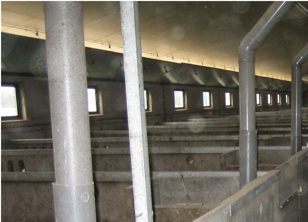
Figuur 15 Directe inlaat met kleppen
