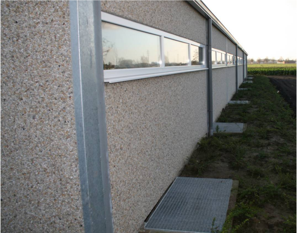
Figuur 36 Luchtinlaat bij kanaalventilatie (ondergronds)
