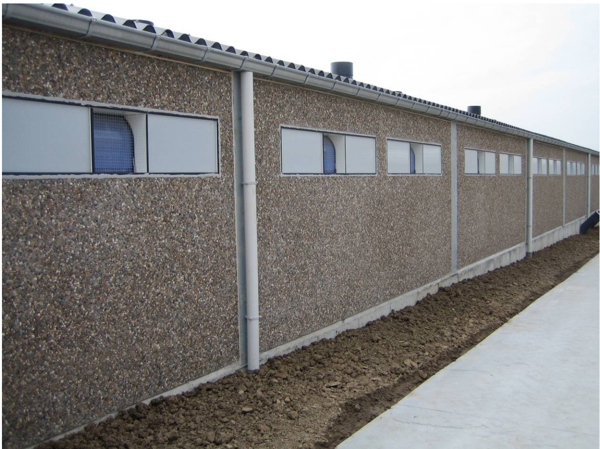
Figuur 18 Inlaatventiel (buitenzicht)
