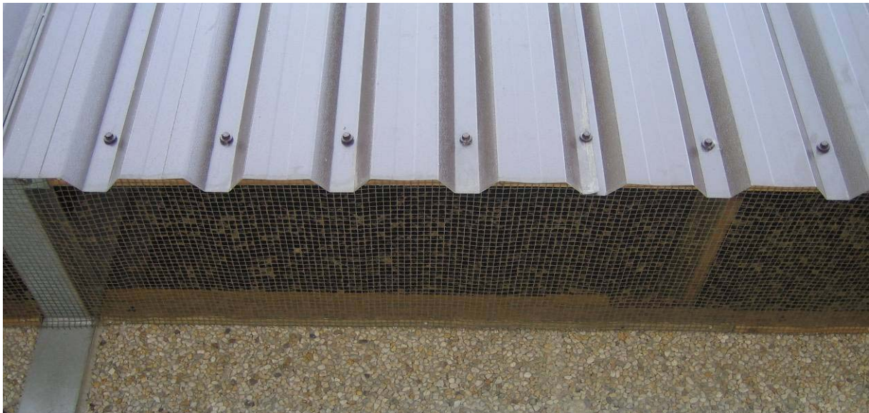
Figuur 12 Indirecte luchtinlaat
