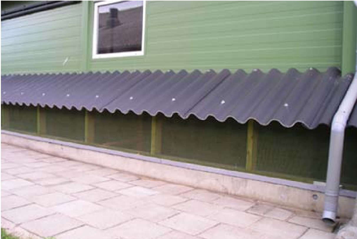
Figuur 35 Luchtinlaat bij kanaalventilatie (bovengronds)
