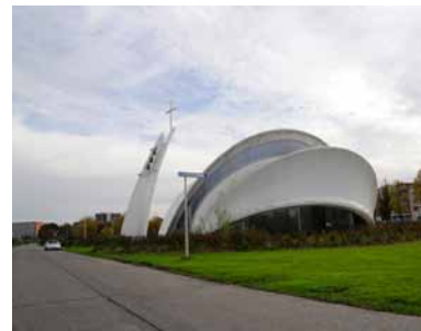
Gebouw met bijzondere functie wijkt af in massa, opbouw en vorm
