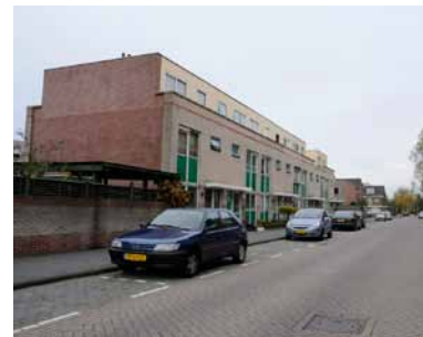
Platte dakopbouw op een plat dak terugleggen van de voorgevellijn
