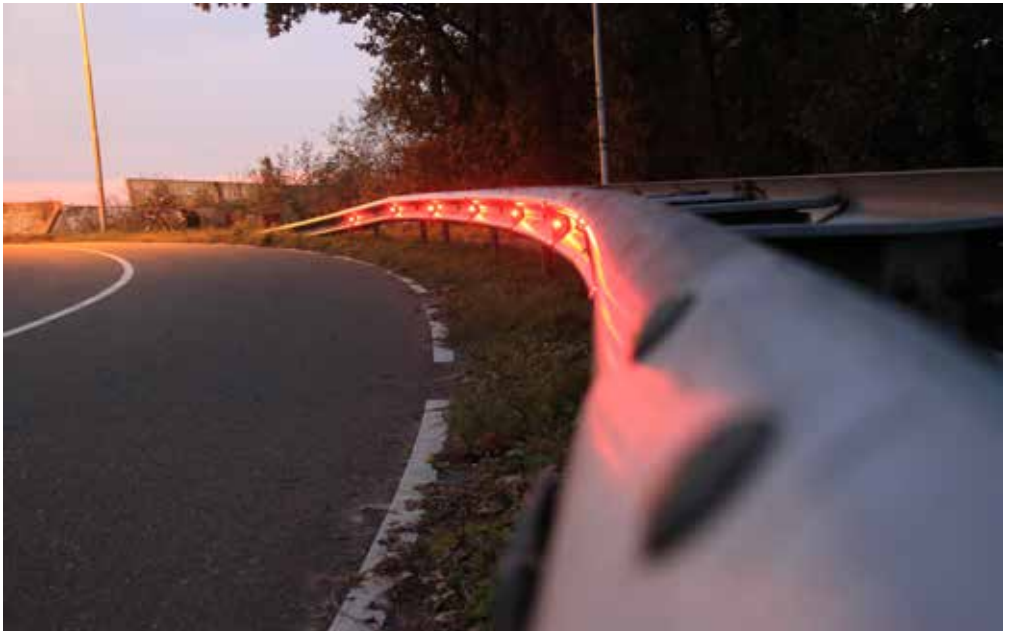
Vangrailverlichting op plantenstroom.
