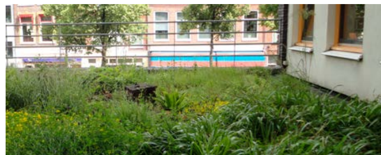
Schaduwnatuurdak op hoofdkantoor Stadsontwikkeling Zuiderdiep in Groningen.
