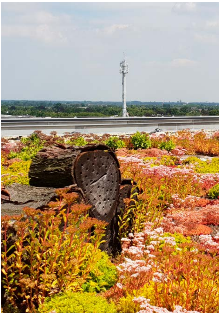
Extensief begroeid dak met sedum, een soort vetplantjes.
