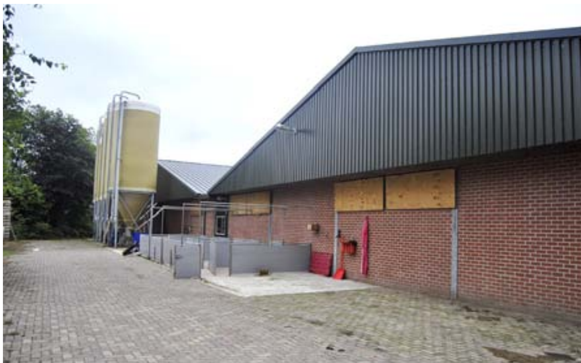
[vervangen door luchtfoto, res niet voldoende]
