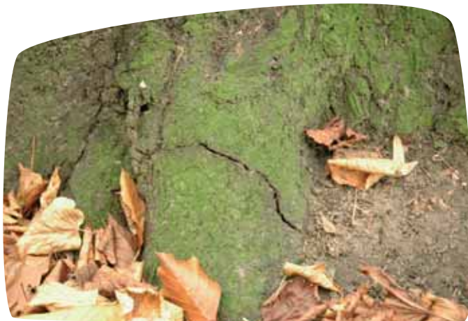
Een dwarsscheur, zoals op deze wortelaanzet, is een ernstig defect.
