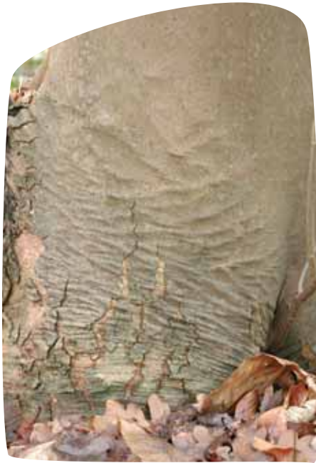
Opstuikende schors aan de zijde die van de wind is afgekeerd, kan wijzen op vezelknikken.
