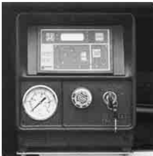
Fig. 3.5 Motorbeveiliging van een regeninstallatie
