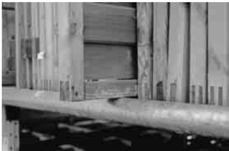
Fig. 1.14 Verkleuring van het hout door de zon.
