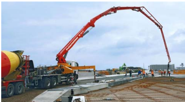
Figuur 3. Betonpomp en kubel.
