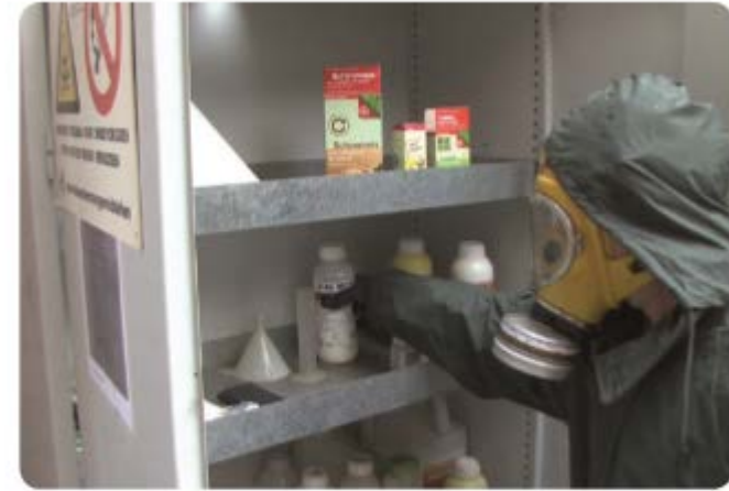
Afb. 2 Een bestrijdingsmiddelenkast met vloeistoffen in lekbakken. Een kleinere kast mag ventileren op een ruimte waarin niet permanent gewerkt wordt, zoals een werktuigenloods.
