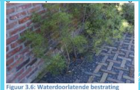
Figuur 3.6: Waterdoorlatende bestrating
