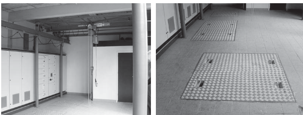
Figuur 6.30 Schakelruimte met hijsvoorziening pompen en hijsluiken
