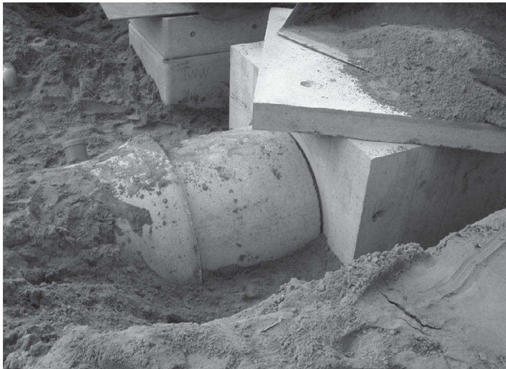
Figuur 6.14 Toepassing pasbuis bij aansluiting op rioolput
