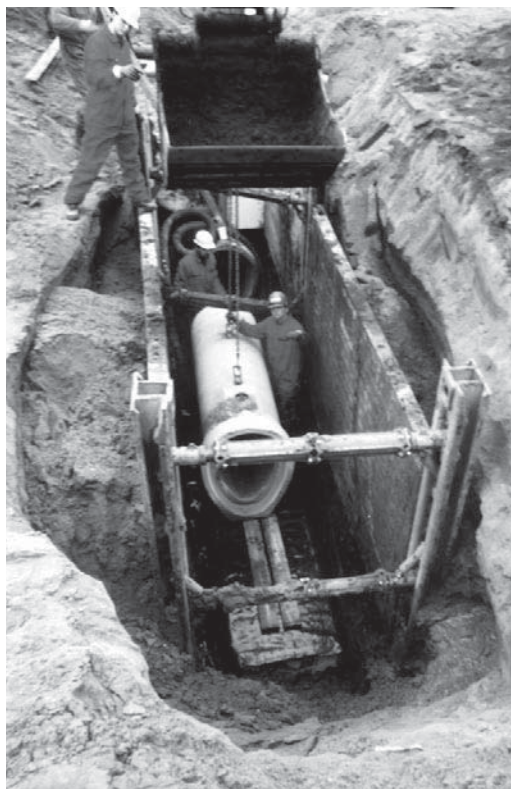
Figuur 6.55 Rioolsleuf zonder en met [VPB] sleufbekisting
