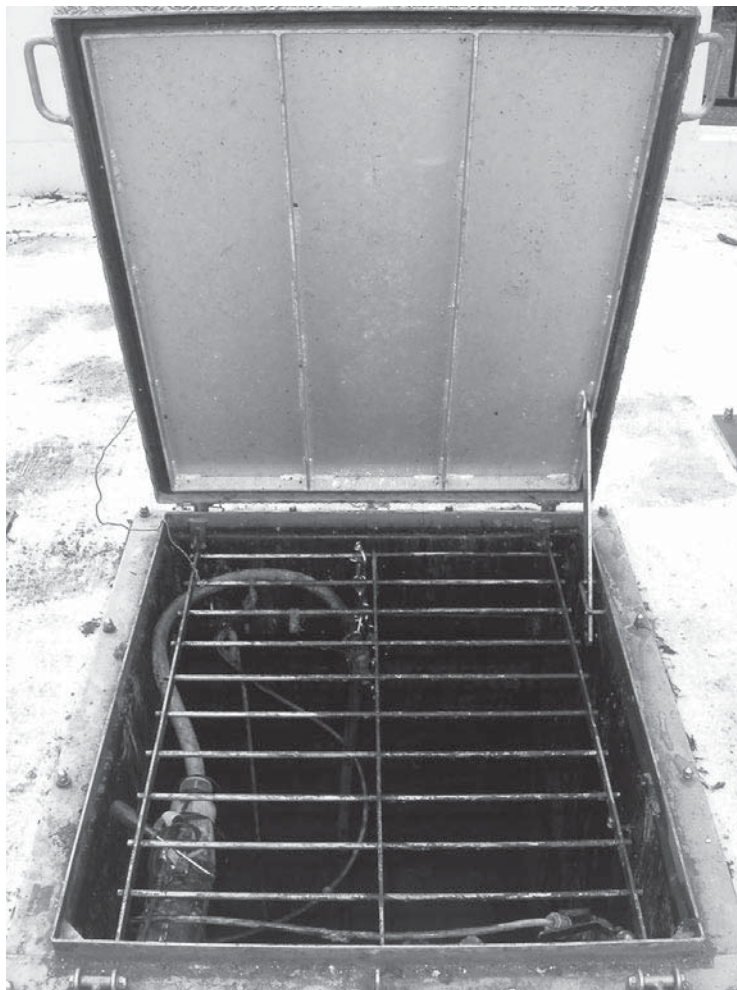
Figuur 6.60 Valbeveiliging onder hijsluik vuilwaterkelder
