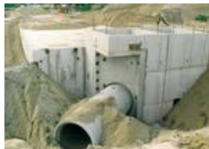
Figuur 21: rioolpompen en zojuist geplaatste betonnen rioolput. Bron: http://www.landustrie.nl
