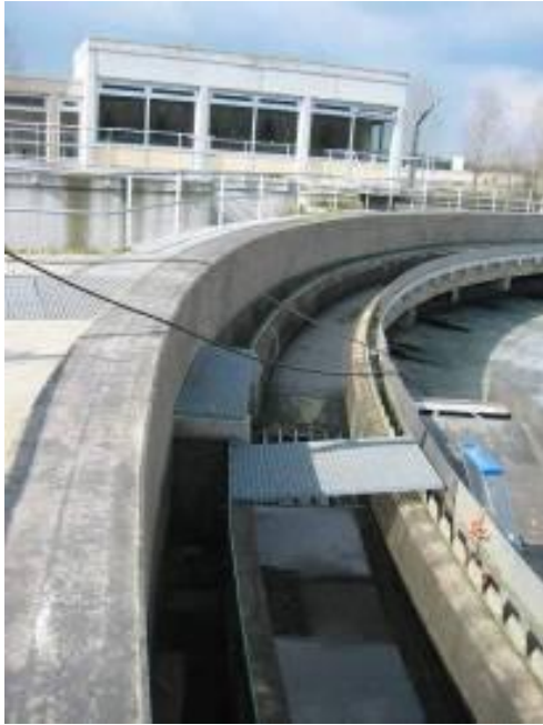
Figuur 29: inkepingen in de rand van de eerste bezinktank. Het water met zwevende delen en opgeloste stoffen vloeit over de rand en gaat door naar de volgende bewerking. Drijvende delen worden door de V-groeven tegengehouden.
