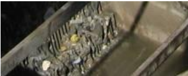
Figuur 24: een rooster met grove spullen uit het rioolwater.
