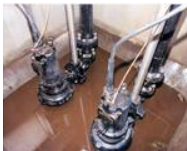
Figuur 21: rioolpompen en zojuist geplaatste betonnen rioolput. Bron: http://www.landustrie.nl
