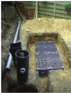
Afbeelding: wateropvangsysteem in kleinere tuin voor bijvoorbeeld hergebruik tbv een toilet.
