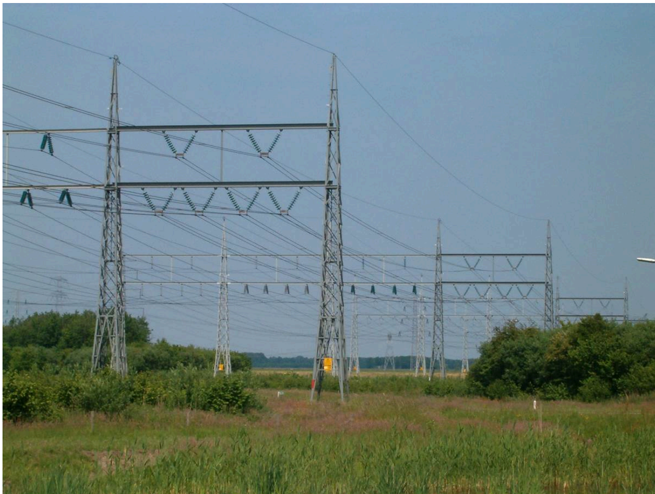
overkoken hoogspanningsmast
