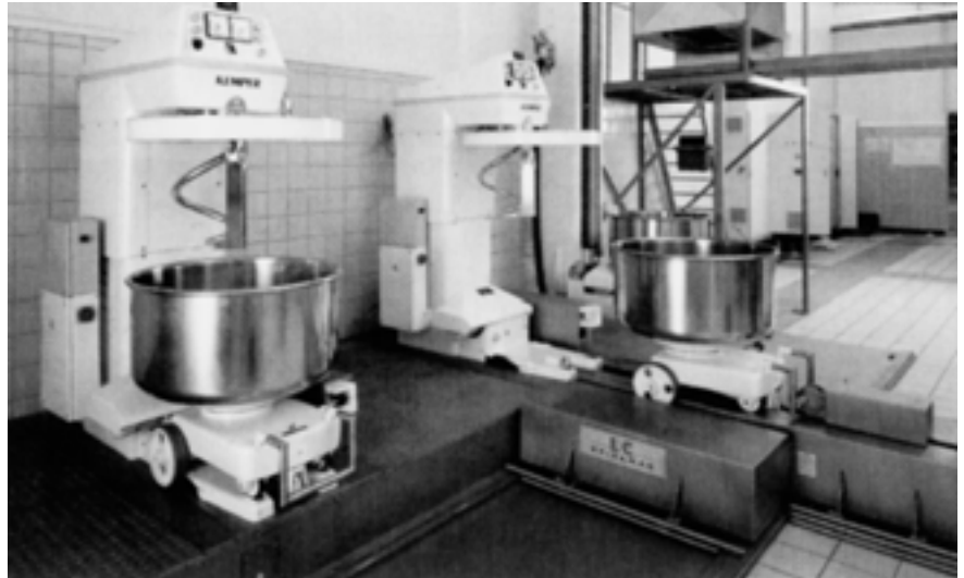
Fig. 3.5 Geautomatiseerd kuipwagentransport (Holtkamp)
